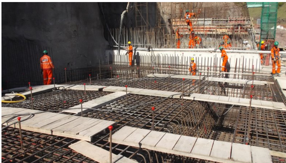
Figura 3-1: Laje de soleira com altura de 2,0 m.
